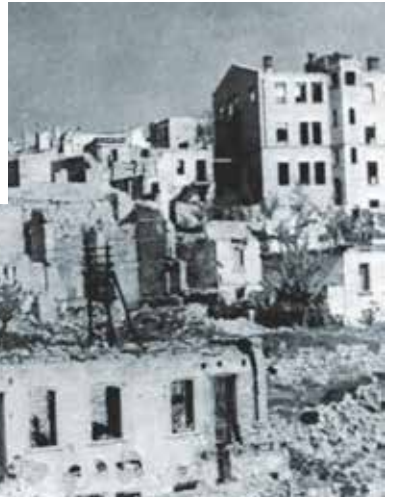
Разрушенные дома на ул. Ленина. 1944 г.
