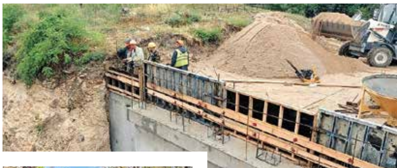
Капремонт путепровода на Госпитальном спуске
